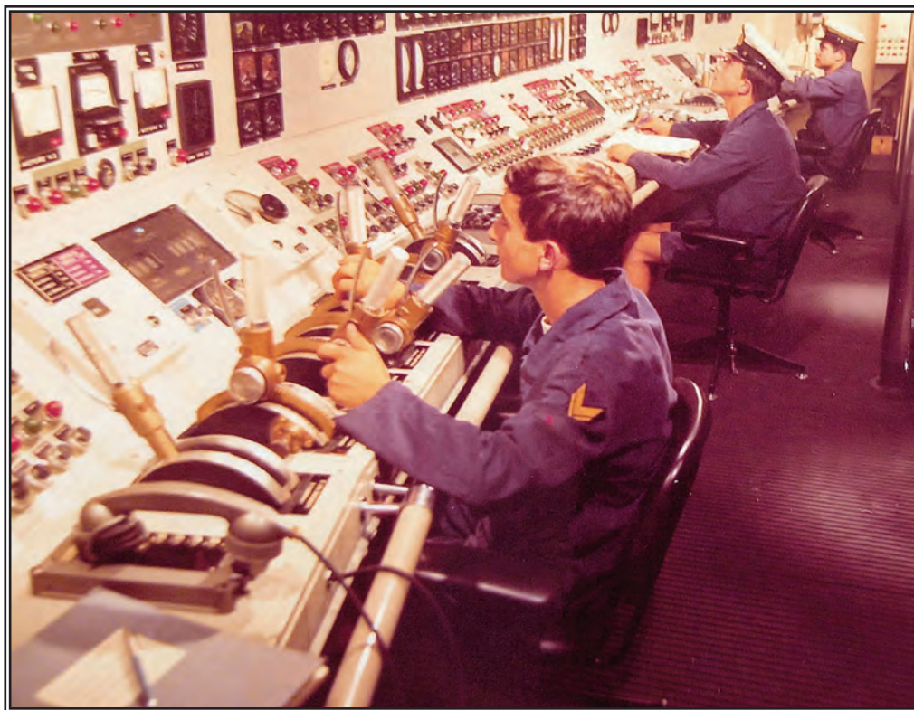
La centrale operativa di piattaforma della fregata Carabiniere , dalla quale si potevano controllare le macchine (Fototeca dell'Ufficio Storico della Marina Militare, Roma)
