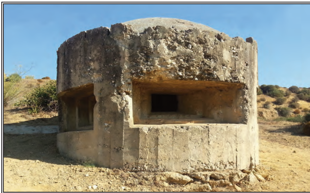
Casamatta lungo la strada che da Vittoria conduce a Gela, in provincia di Ragusa
