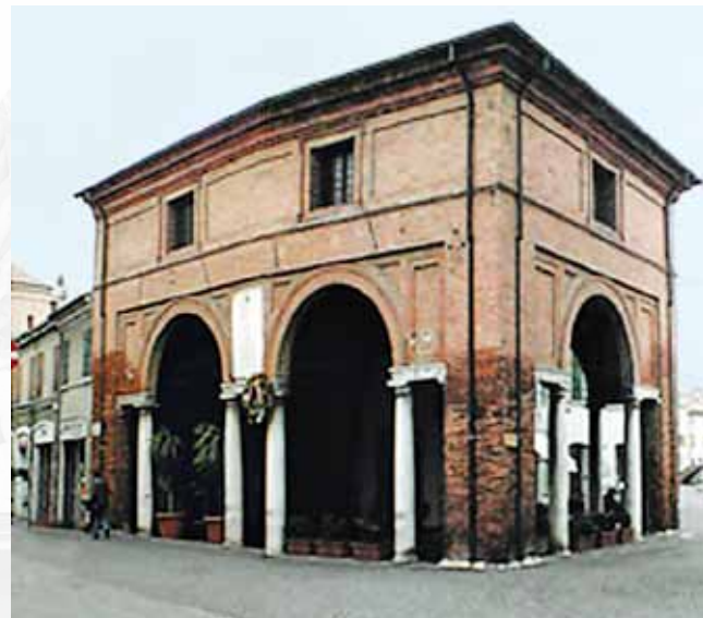
Loggia dei Mercanti del grano (Comacchio)
