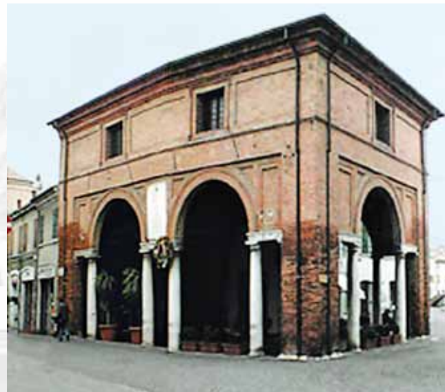
Loggia dei Mercanti del grano (Comacchio)
