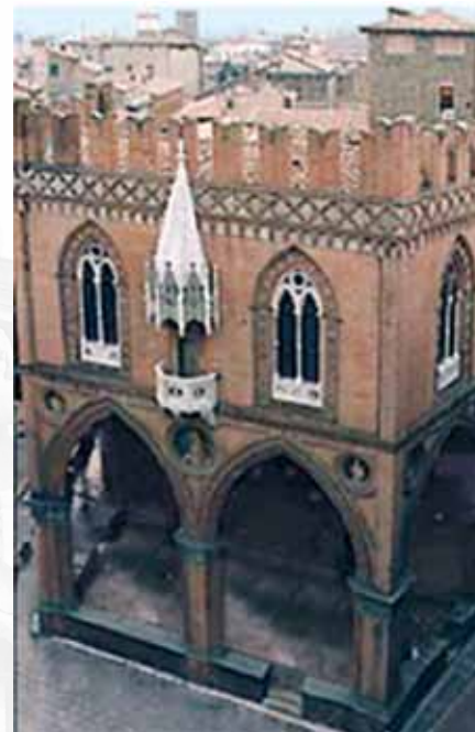
Loggia dei Mercanti (Bologna)
