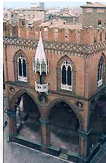
Loggia dei Mercanti (Bologna)
