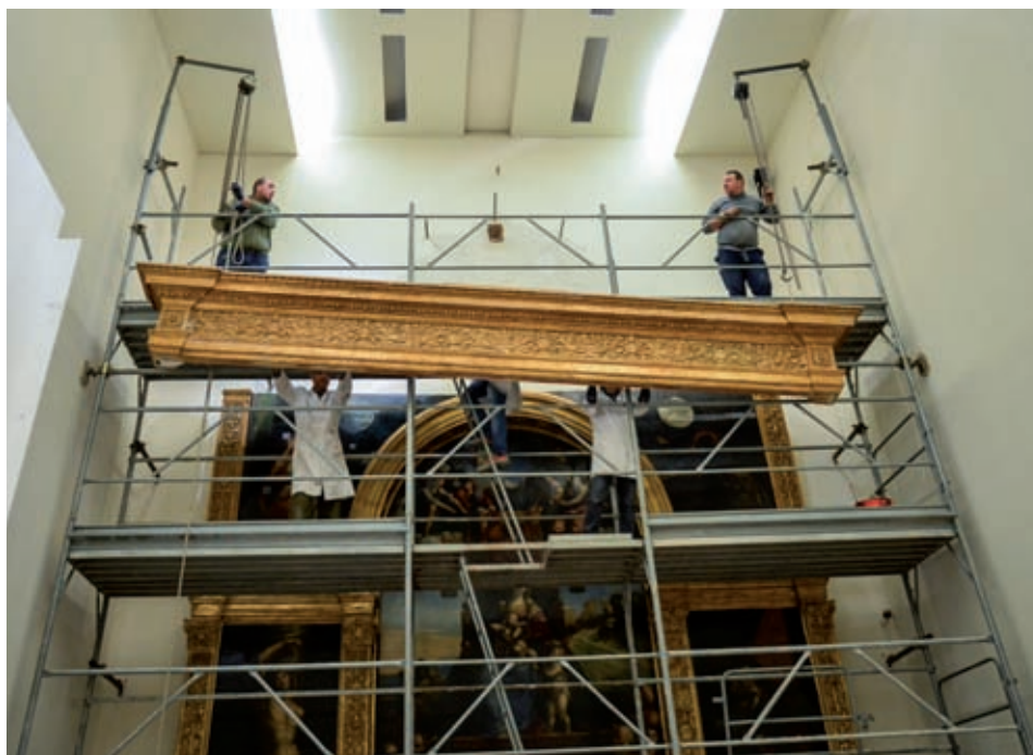
Fig. 1. Smontaggio del polittico Costabili
